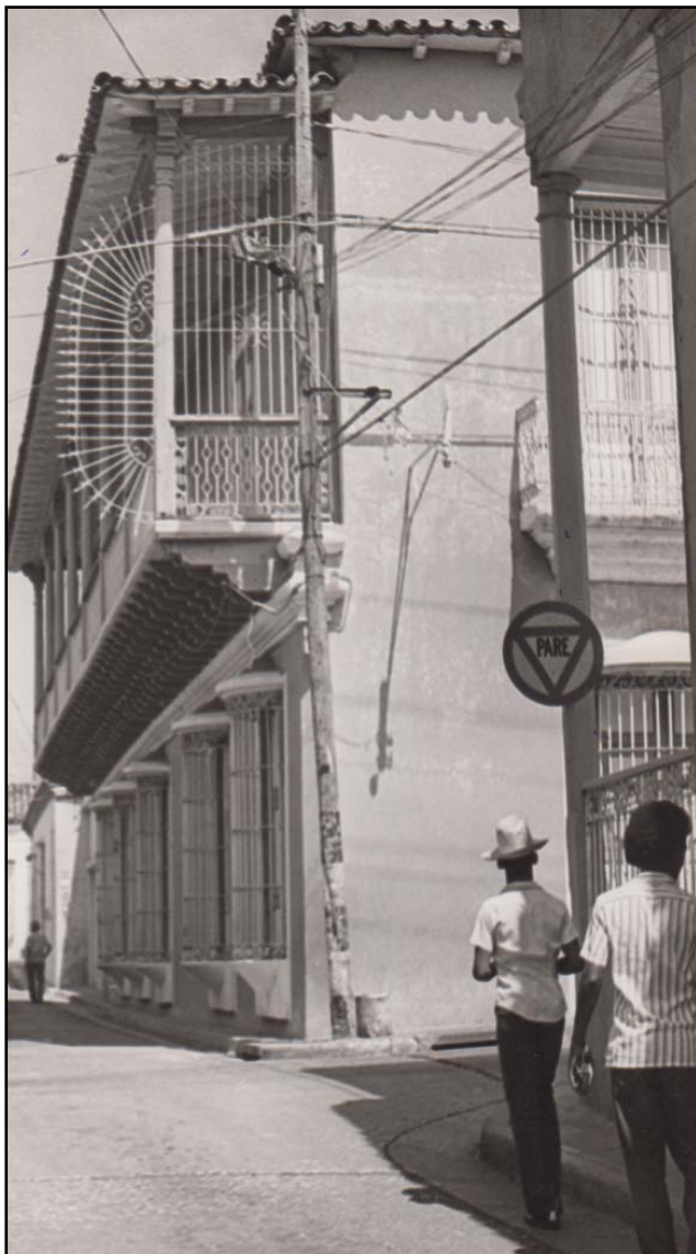
En esta casa de la calle Santa Lucía y San Pedro, en Santiago de Cuba, radicó el Cuartel General del levantamiento de la ciudad santiaguera para apoyar el desembarco.
