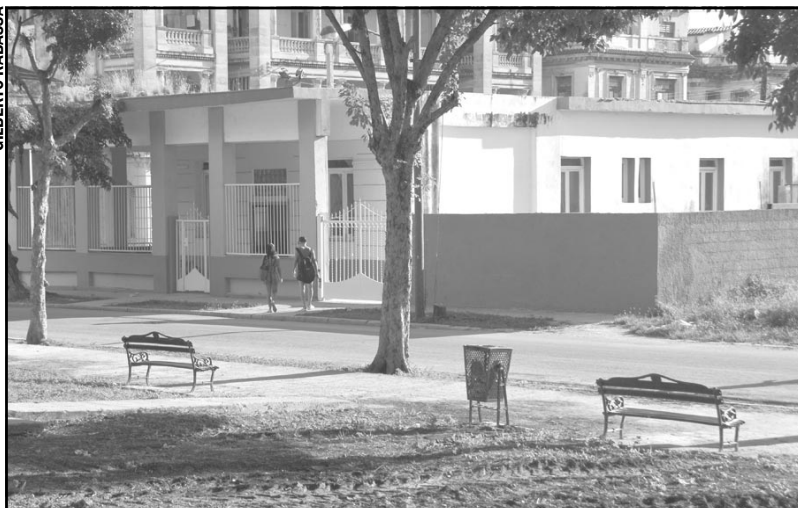
Una de las obras realizadas en Cuba por el Proyecto Sviluppo es la reestructuración del hogar de ancianos Manuel Aneiro Subirat, en Plaza de la Revolución. Aunque esas labores concluyeron hace un año, aún el centro no ha abierto sus puertas.
