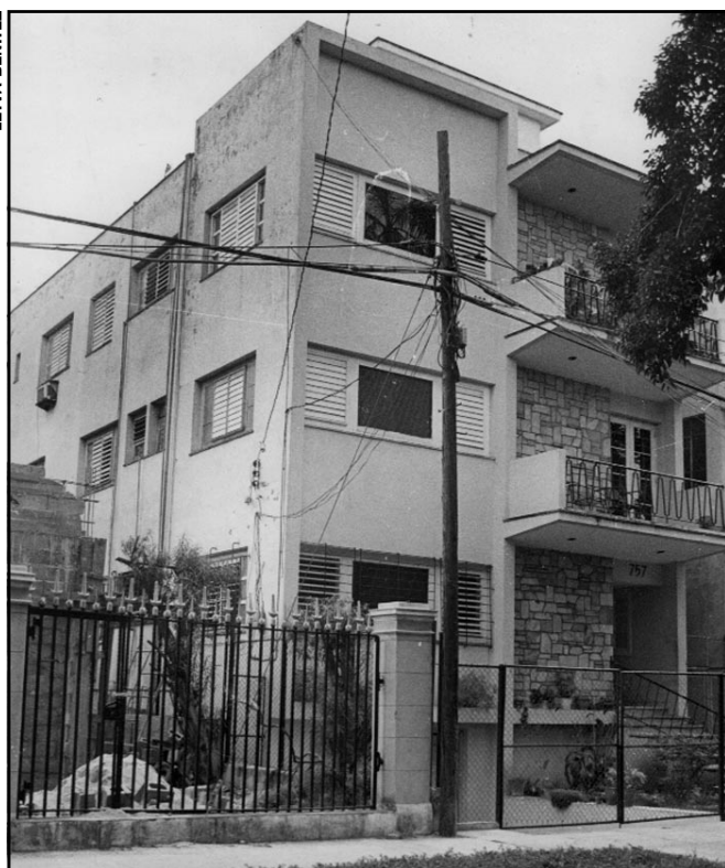
Edificio de la calle 13 casi esquina a Paseo, donde fuera apresado Oscar Lucero.
