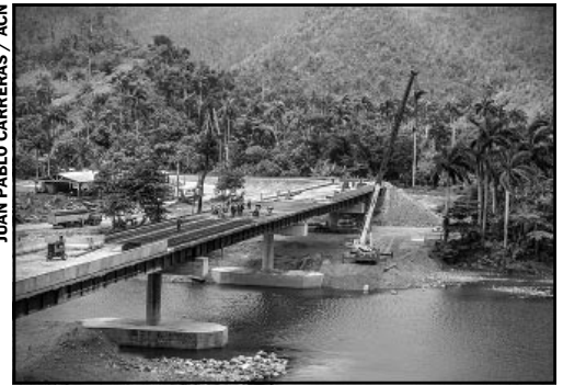
El nuevo puente mide 225 metros de largo por 11 de ancho y es 4.5 metros más alto que su antecesor.
