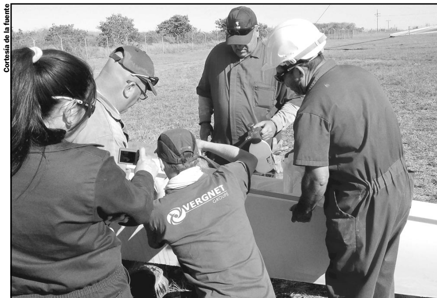
Brigada de Fuentes Renovables de Energía del Parque Experimental Eólico Los Canarreos bajo de la supervisión de un experto del grupo Vergnet.
