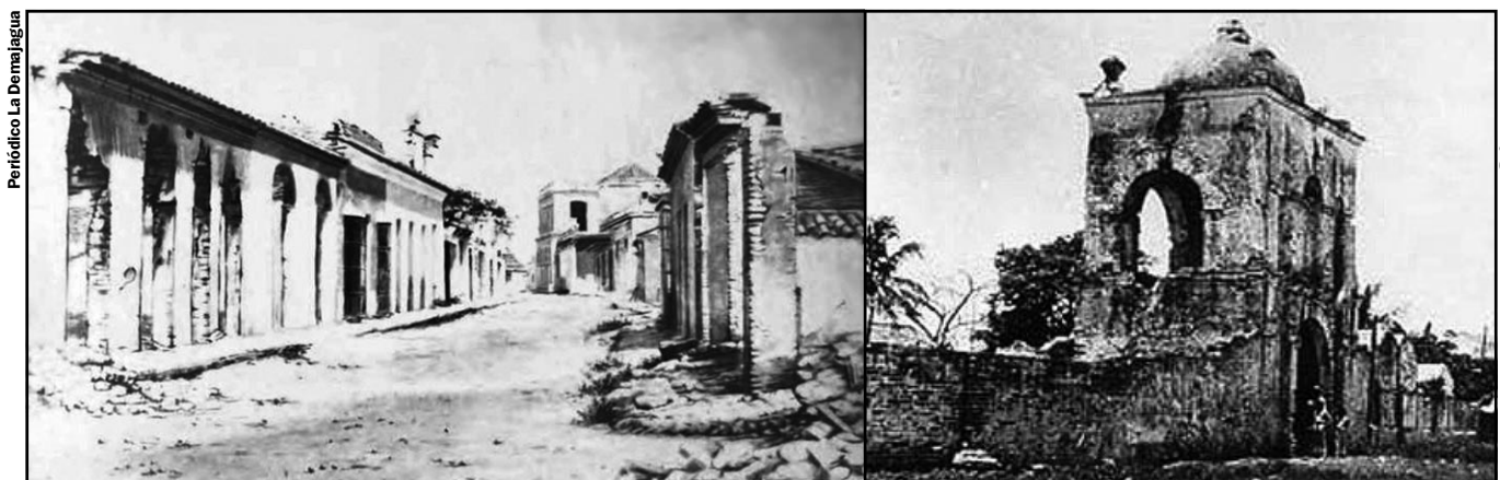
Estado ruinoso de la urbe tras el incendio.
