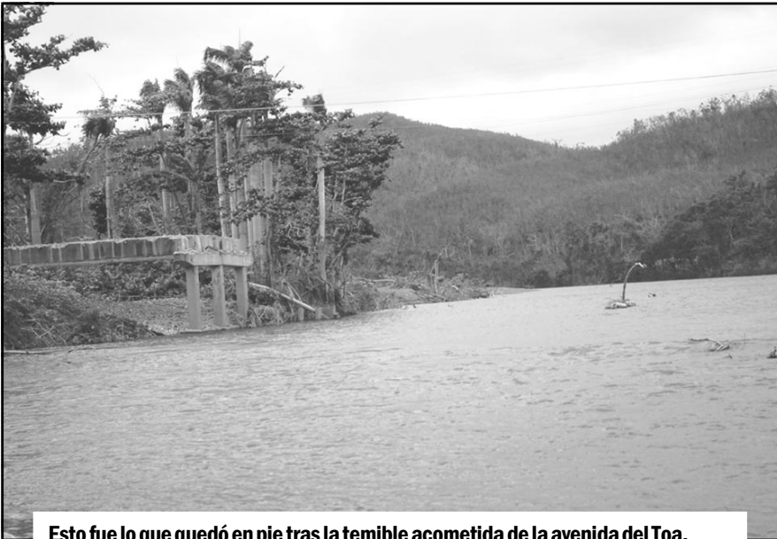
Esto fue lo que quedó en pie tras la temible acometida de la avenida del Toa, provocada por las lluvias del huracán Matthew.
