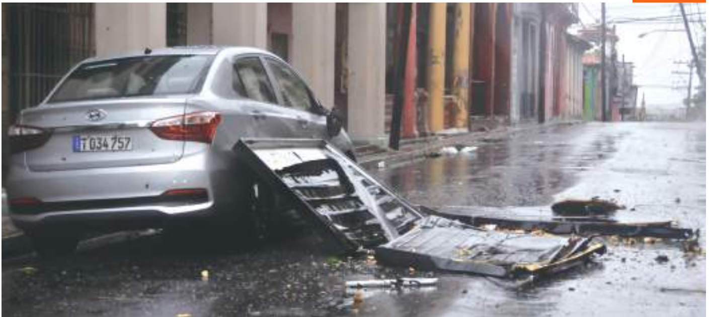
Algunas consecuencias del huracán pudieron ser evitadas, como la caída de un calentador solar desde una azotea.
