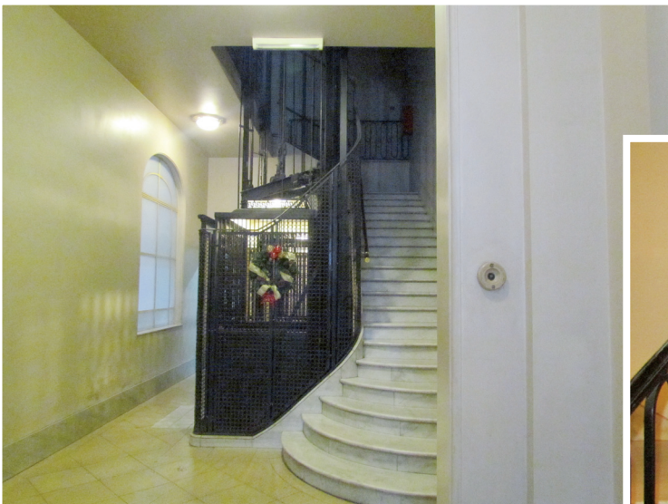
..... Ascensor original que lleva a la segunda planta.
