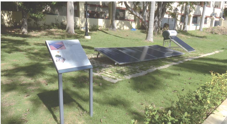
●●●●●●●●●● El Centro Demostrativo de Energías Renovables incluye paneles solares, molinos de viento y agua, bombas de soga y otros artefactos. NAILEY VECINO PÉREZ
